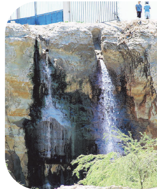
Contaminación por mala disposición de aguas residuales.
