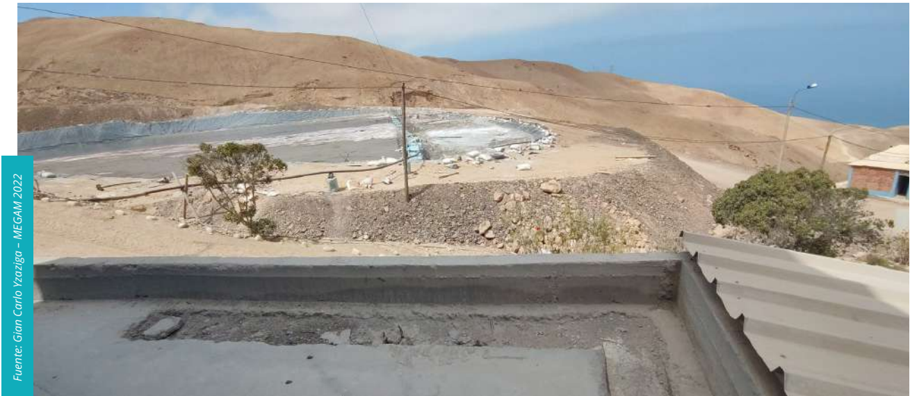
Figura 1. Depósito de relaves por lixiviación cianurada de oro proveniente de una planta de beneficio de la MAPE en Arequipa
