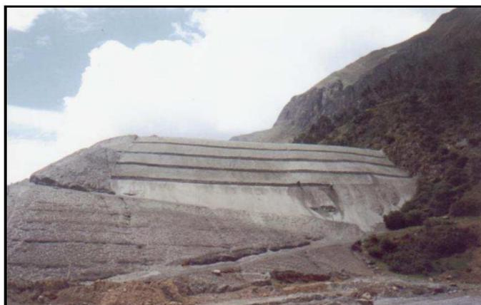
**Foto N° 14. Preparación del talud de una relavera 3 400 msnm**
