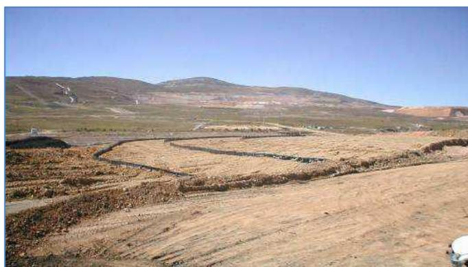
**Foto N° 6. Aplicación de la cerca de sedimento**
