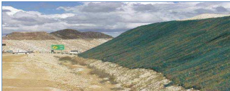
Foto N° 3. Mantas para el control de la erosión
