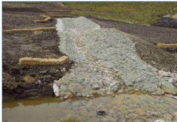
**Foto N° 1. Canal con rip-rap con lechada de concreto**
